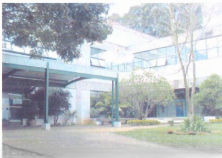
Fachada da Biblioteca Central.
