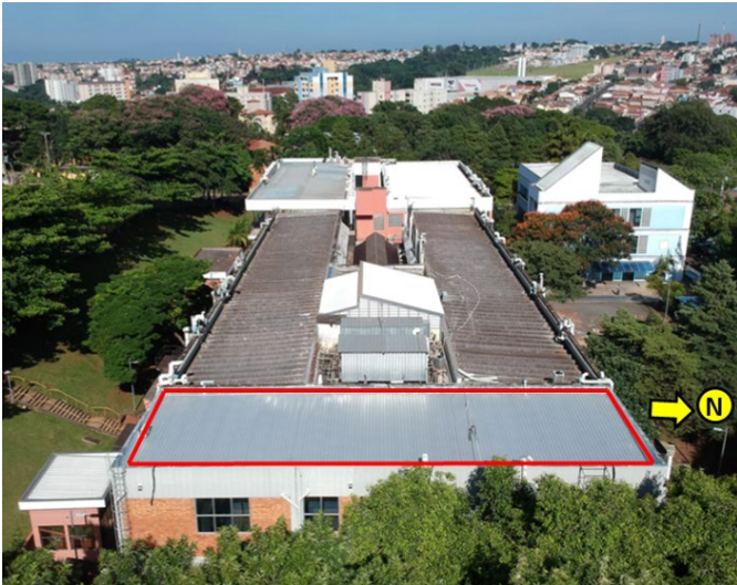
Fig. 11: IQSC - Bloco Q1 - Laboratório
