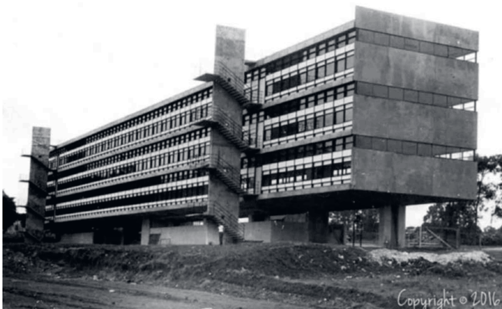
Fig. 2. Prédio E-1 na época de sua construção. Acervo EESC-USP.
