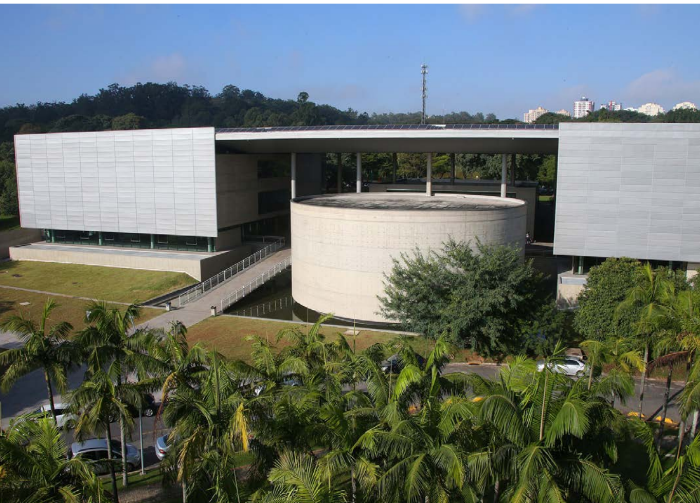
Fig. 16. Espaço Brasiliana (BBM à esquerda, IEB à direita e Auditório István Jancsó no centro).
