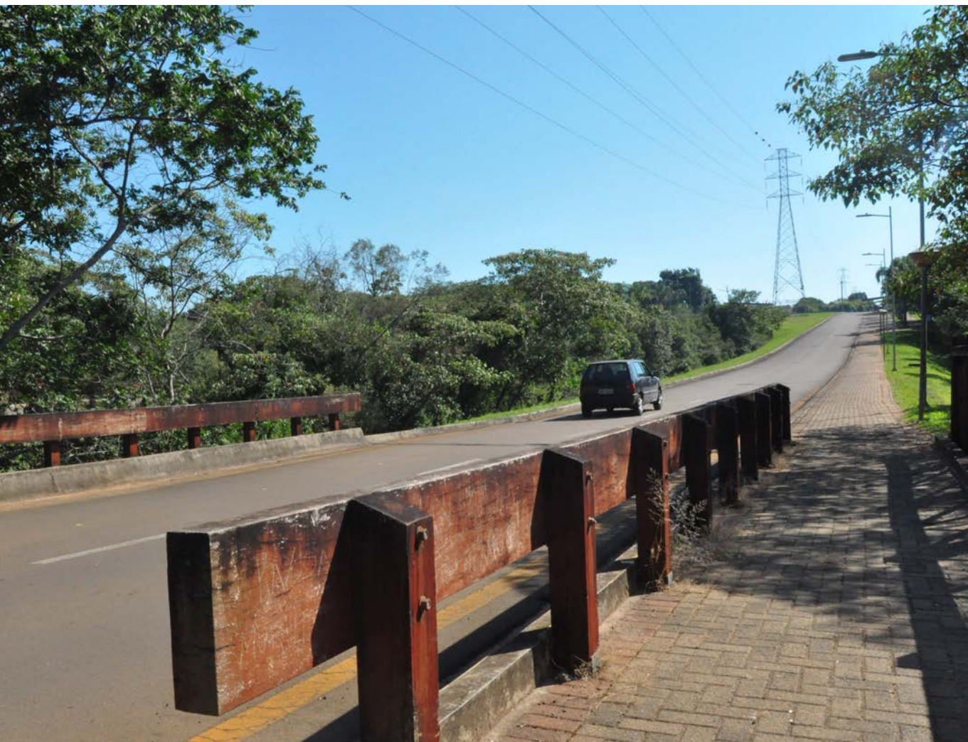
Fig. 16. Ponte de madeira do Campus 2. Suzana Xavier – PUSP-SC.
