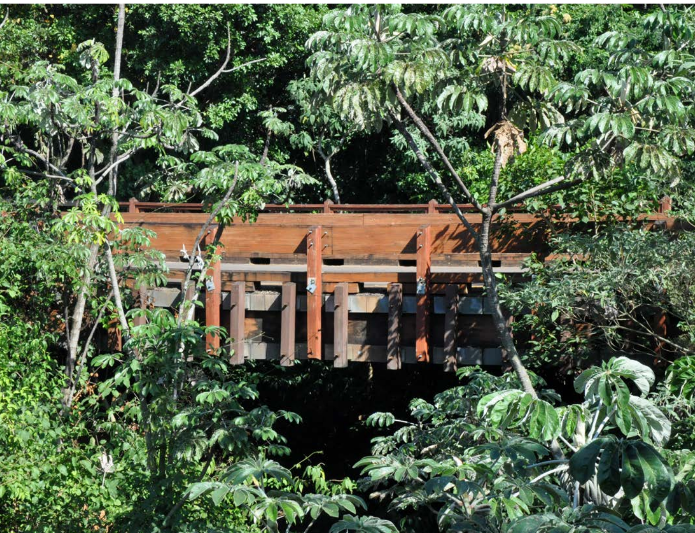
Fig. 17. Ponte de madeira do Campus 2. Suzana Xavier – PUSP-SC.
