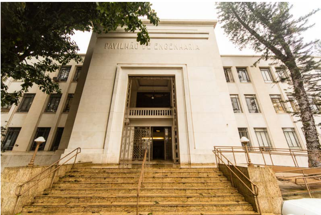
Fig. 10. Fachada do Pavilhão de Engenharia. Gerhard Waller, DvComun, Esalq/usp.
