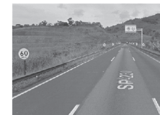
Depois da intervenção a partir dos resultados obtidos no simulador de direção – alteração da sinalização antes da curva no km 514+650 m da Rodovia Régis Bittencourt.
