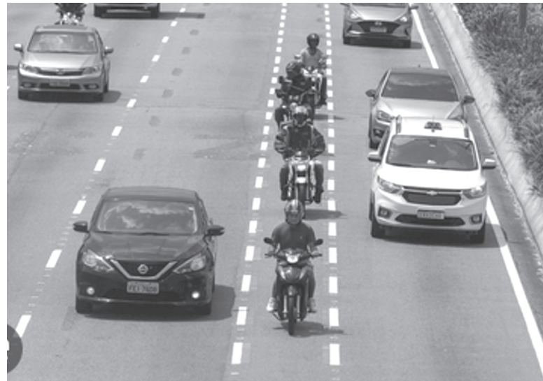
Figura 17.1 – Sinalização de faixas para motocicletas.
