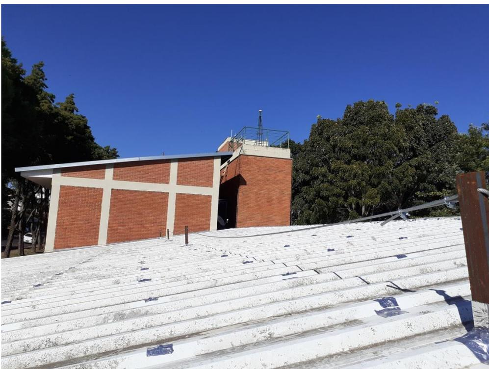
Na cobertura mostrada acima e conforme identificada e detalhada em projeto deverá ser realizado a instalação de 11 linhas de perfil cartola de 4cm de altura e 0,65mm de espessura para apoio da nova telha que será instalada.
