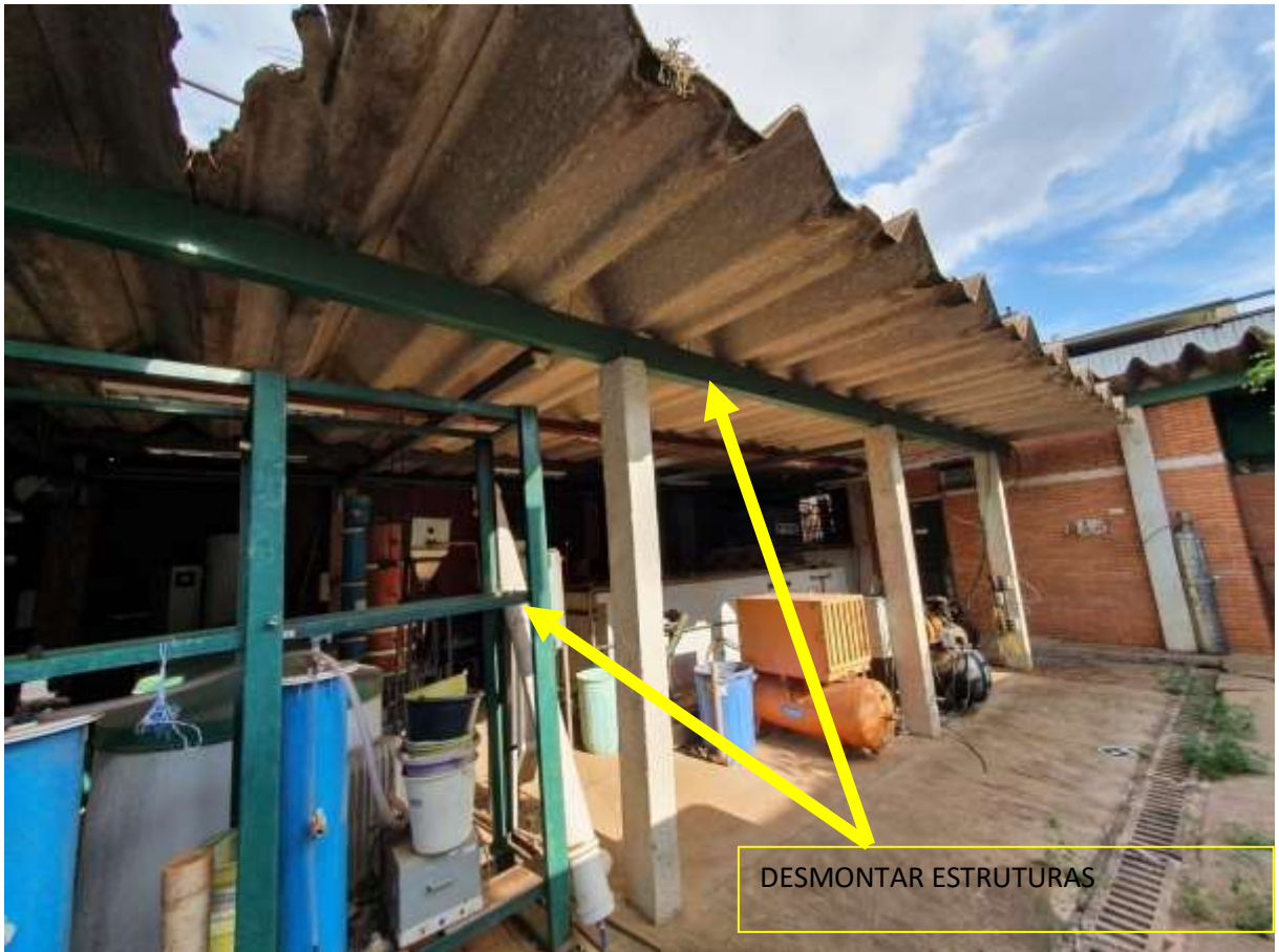
Estruturas antigas a serem desmontadas (incluindo cobertura) e descartadas pela CONTRATADA
