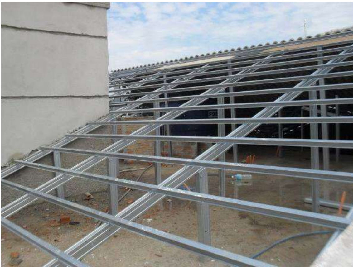
Exemplo de estrutura de cobertura em steel frame
