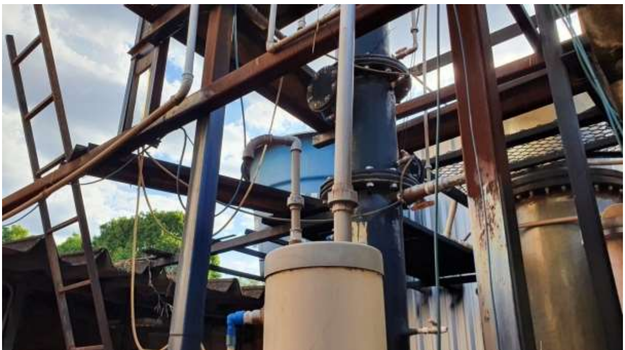
Estruturas antigas a serem desmontadas e descartadas pela CONTRATADA
