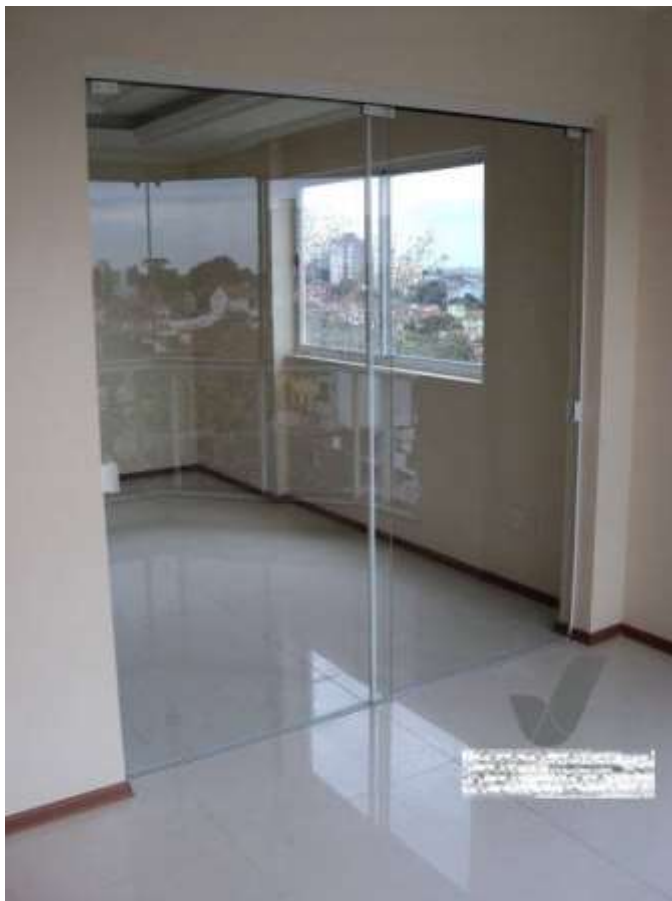
Porta dupla de vidro 10,0mm, duas folhas de correr, com trilho inferior embutido no piso
