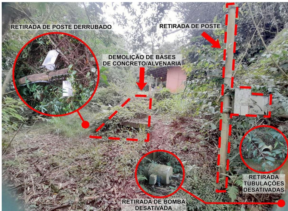
Foto: Remoções próximas da Casa "Abrigo" de Bombas Hidráulicas – Lado SUL
