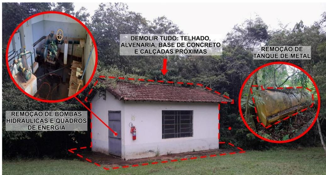
Foto: Casa “Abrigo” Para Bombas Hidráulicas (à margem do rio) – Lado NORTE
