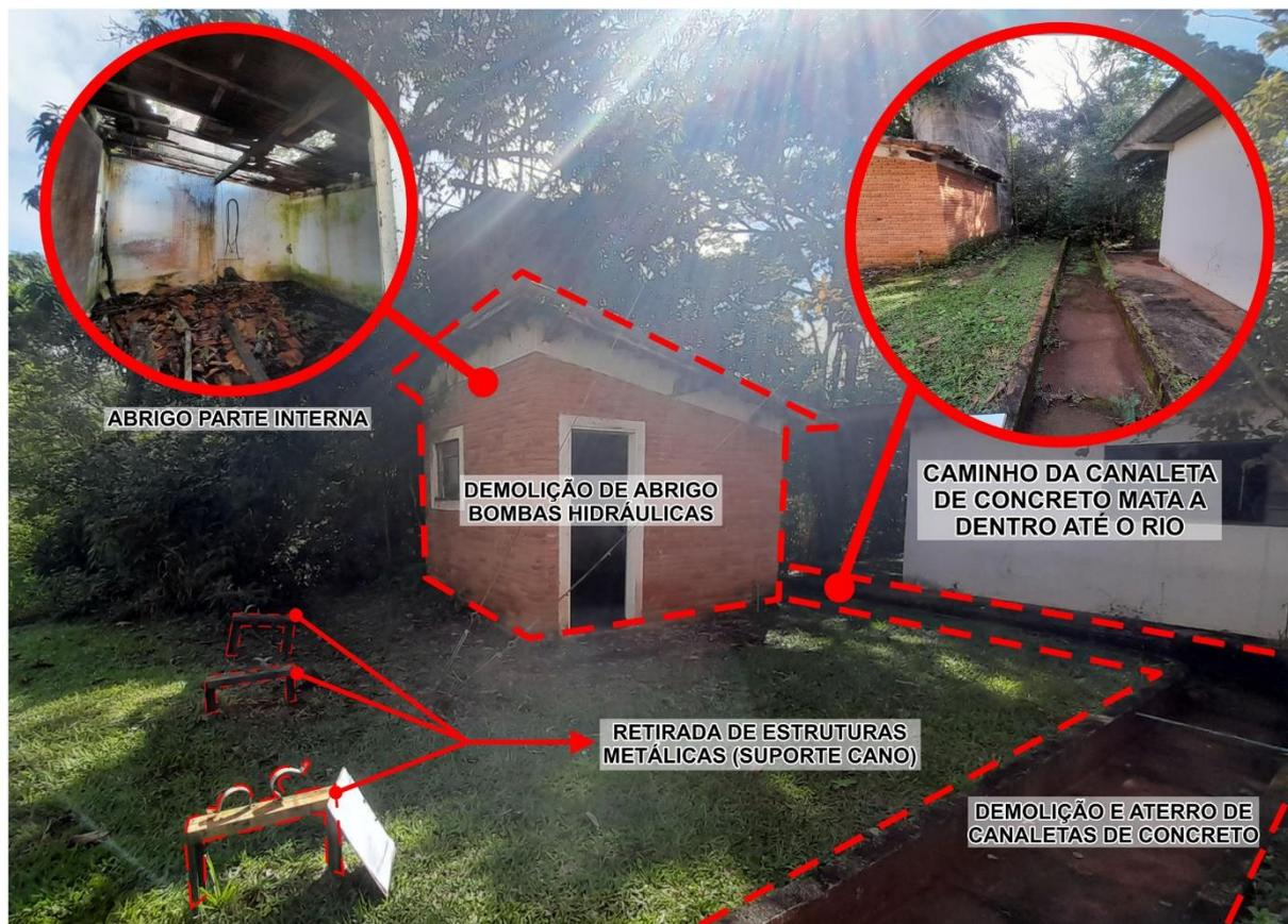
Foto: Casa "Abrigo" Para Bombas Hidráulicas, Canaleta (Condutor) de Água, Estruturas Metálicas (Suporte Cano) – Lado NORTE
