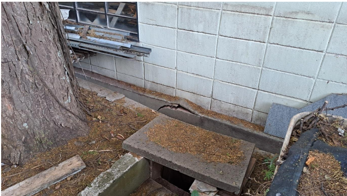
Canaleta a ser demolida
