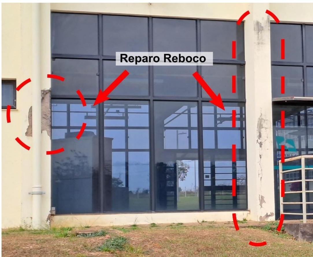
*Edifício Engenharia Aeronáutica: Exemplo de Pontos de Reboco Degradado*
